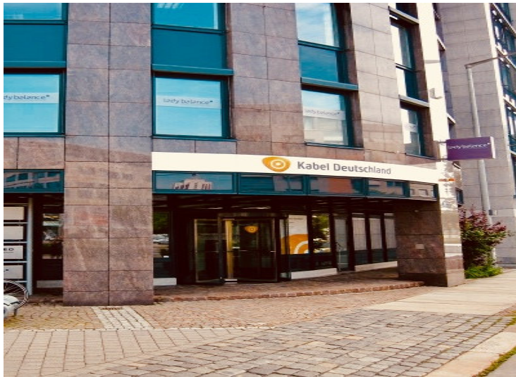
Standort für Telekommunikation
